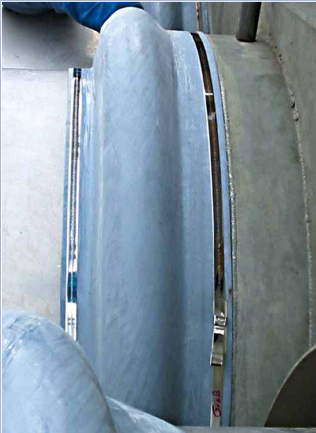
Universalkompensator Typ B310 als Behälteranschluss DN 900 / DN 650, 0,1 bar
