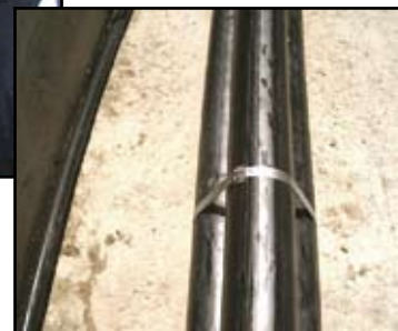
U - Bahn - Verkabelung
