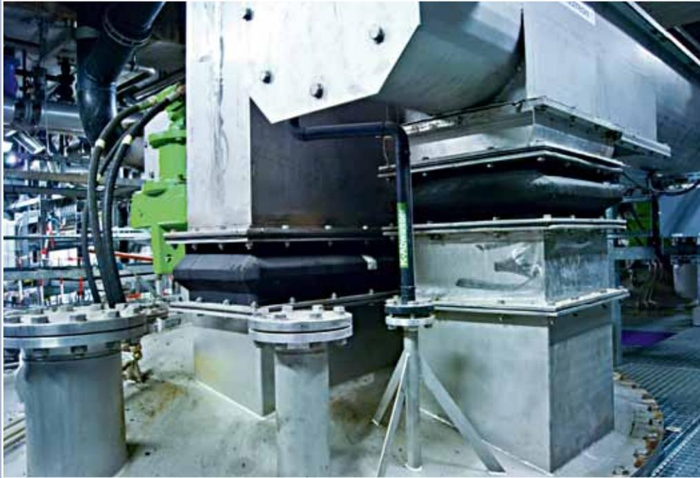
Elastomerkompensatoren Typ GU110
