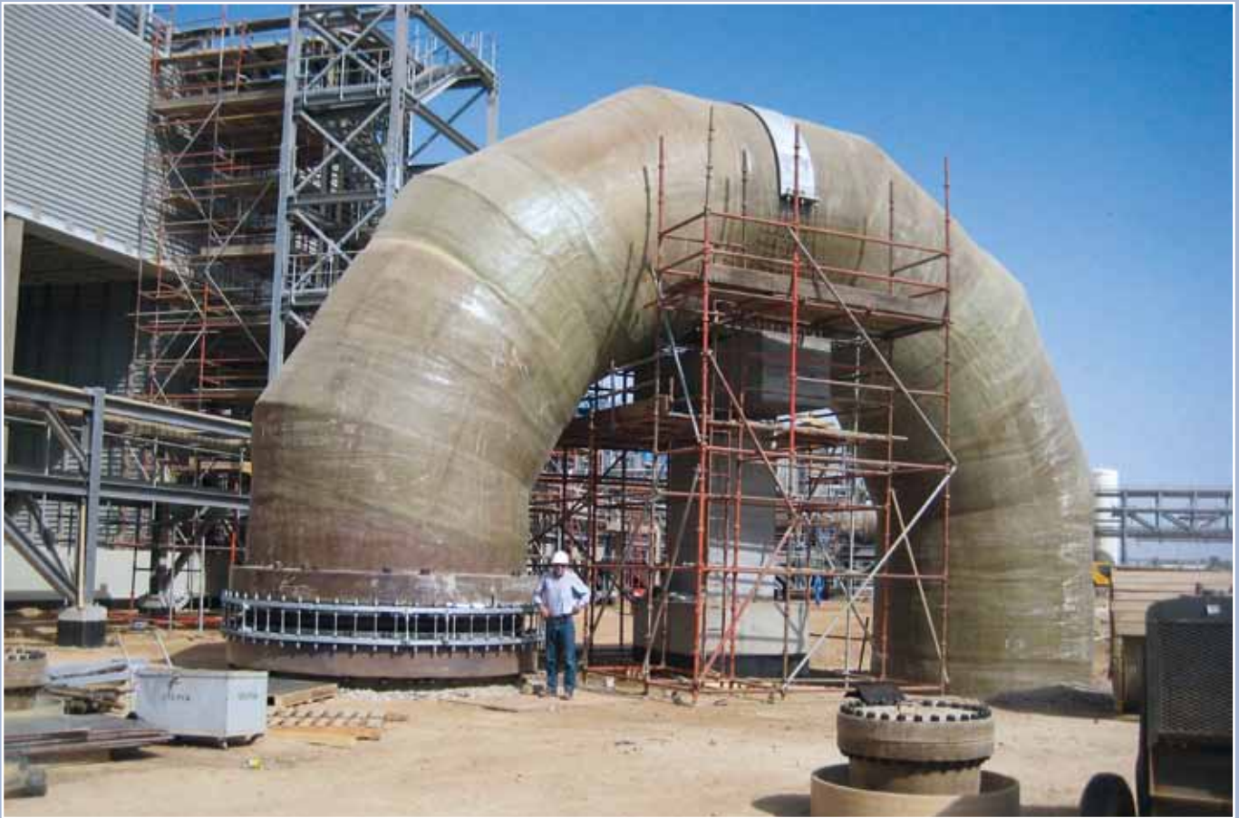
Lateralkompensatoren Typ U110M in einer Meerwasserentsalzungsanlage DN 3600, 8 bar, 90°C
