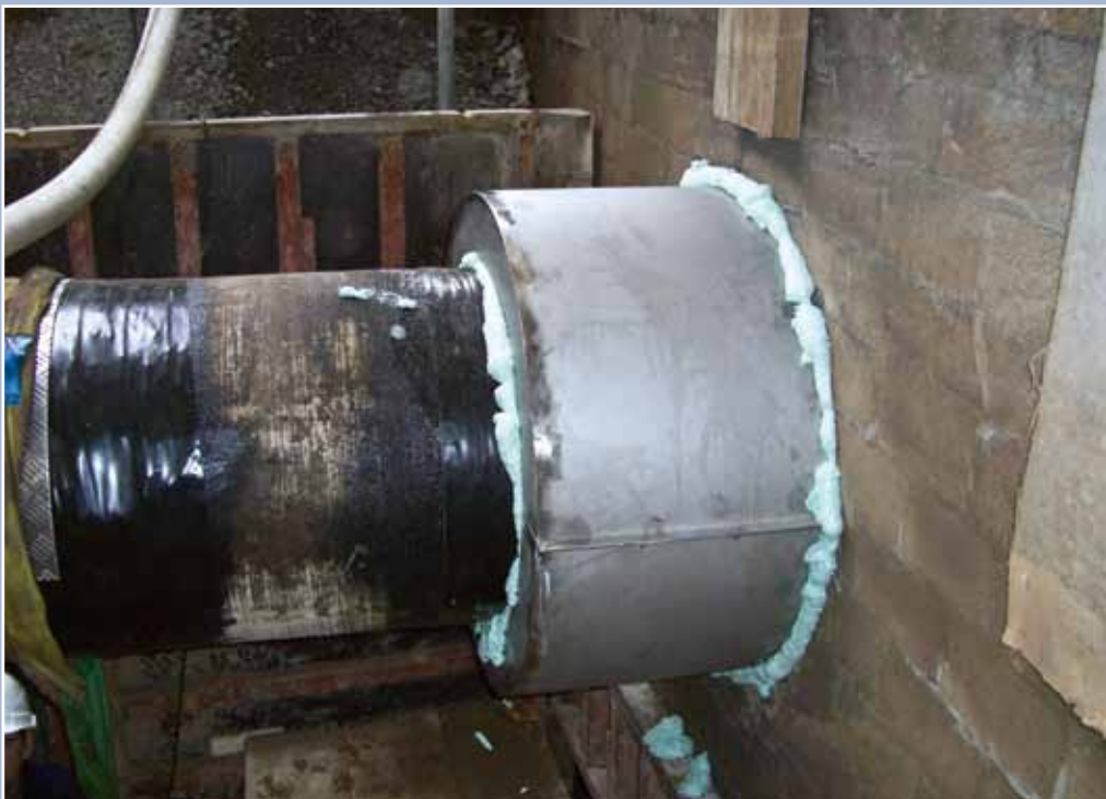
... nach der Montage einer Erdabdeckhaube
