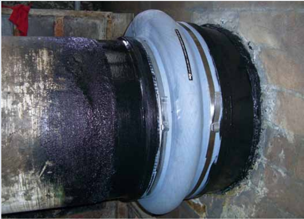
Wandabdichtung Typ W111SS an einer Kühlwasserleitung in einem Kernkraftwerk DN 700 / DN 600, 0,25 bar von außen
