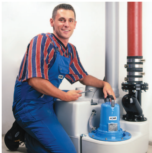
>> Angeschlossene Druckleitung (rot) und Entlüftungsleitung (grau) bei Sanistar-Hebeanlagen
